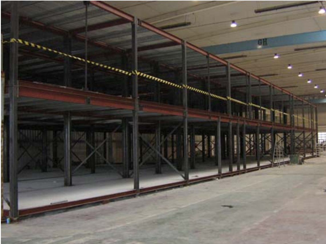
Mòduls de l'edifici de Torelló durant el procés de fabricació
